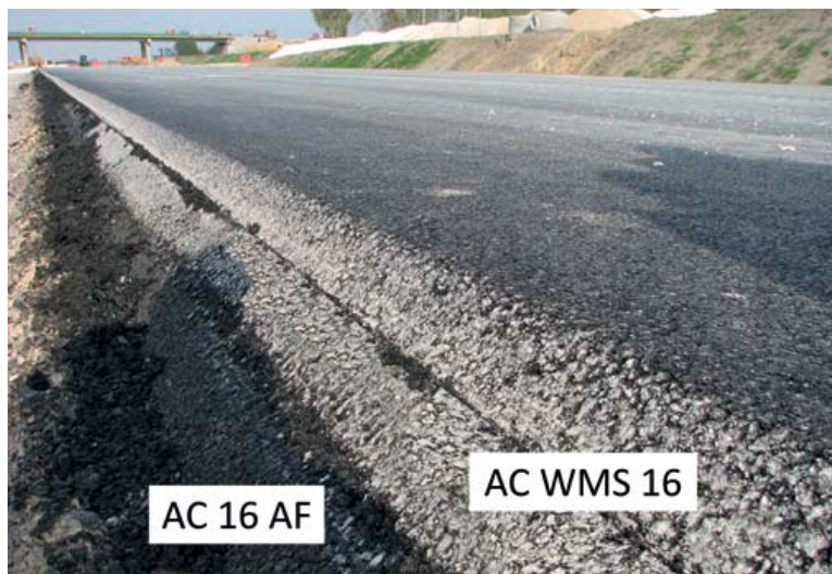
Rys. 10.4. Widok warstwy wiążącej AC WMS 16 ułożonej w dwóch warstwach na warstwie antyzmęczeniowej AC 16 (AF) (fot. M. Sarnowski)
