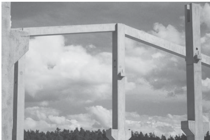
Rys. 26.10. Hala dwunawowa o dźwigarach jednospadowych
