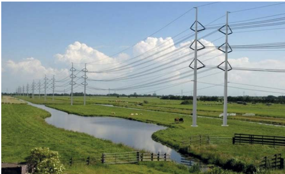
Rys. 19.18. Nowoczesne rozwiązania linii napowietrznych wysokich napięć według [2.47]
